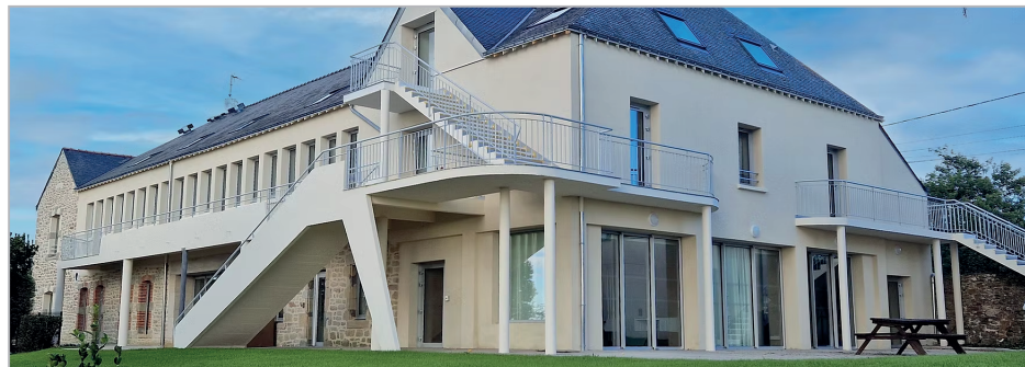
Résidence Les Salines à La Trinité-sur-Mer (56) - Prise en gestion puis réhabilitation d'un ancien centre de vacances pour loger des jeunes et saisonniers - Association Agora Services
